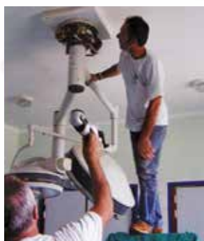
2011-Volontari per il montaggio della sala operatoria al Solomeo Rural Hospital
